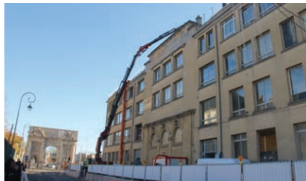
L'ancien bâtiment de l'Institut agricole colonial de Nancy, rue Sainte-Catherine, est en cours de rénovation. Il accueillera, au printemps 2025, un restaurant interadministration.
