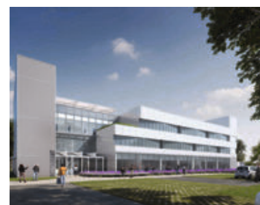
La cuisine d'apprentissage et le restaurant d'application se situent au rez-de-chaussée du futur bâtiment.
